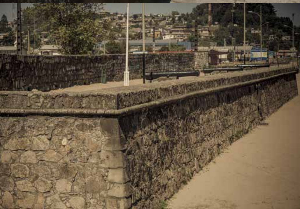
Vista a los cañones del Fuerte La Planchada.
